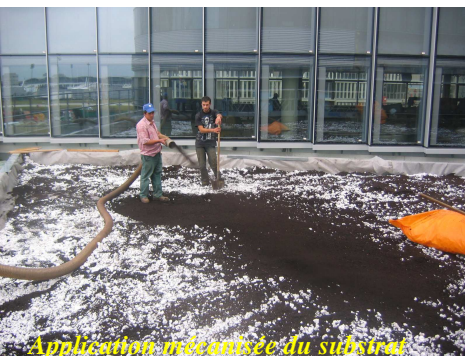
Application mécanisée du substrat
